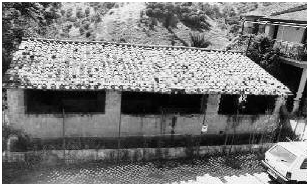
6 - FONTANILE E LAVATOIO PUBBLICO DI MENTANA
