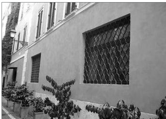
Fig. 12 - VEDUTA DELLO STABILE DOVE SORGEVA LO STUDIO BENAGLIA. ROMA, VIA DELLE ORSOLINE N. 27-31
