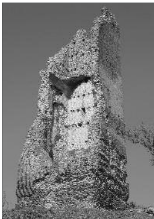
Fig. 10 - TORRE FIORA, VEDUTA DEL FRONTE CROLLATO SUD-OVEST E DEL FRONTE SUD-EST
