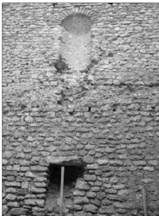
Fig. 14 - TORRE FIORA, VEDUTA DELLA NICCHIA ALL'INTERNO DELLA TORRE E DEL PARAMENTO MURARIO INTERNO
