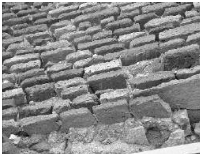
Fig. 13 - TORRE FIORA, PARAMENTO MURARIO ESTERNO IN LATERIZI
