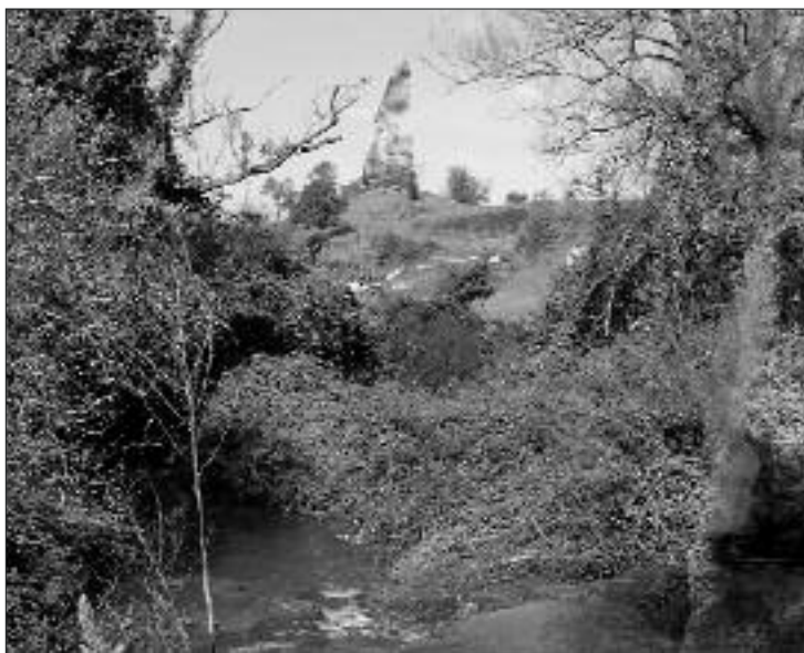
Fig. 1 - PALOMBARA SABINA (RM), TORRE FIORA: VEDUTA DEL FRONTE SUD-EST DAL FOSSO DELLA FIORA
