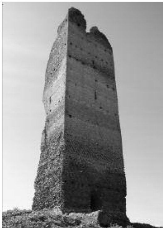
Fig. 9 - TORRE FIORA, VEDUTA DEI FRONTI SUD-EST E NORD-EST. IN BASSO È VISIBILE LA FONDAZIONE IN BOZZE DI CALCARE
