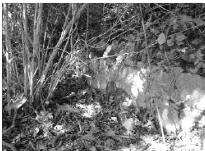
Fig. 16 - FOSSO DELLA FIORA, TRATTO DI MURO IN BOZZE DI CALCARE RIVESTITO DA INTONACO TINTEGGIATO
