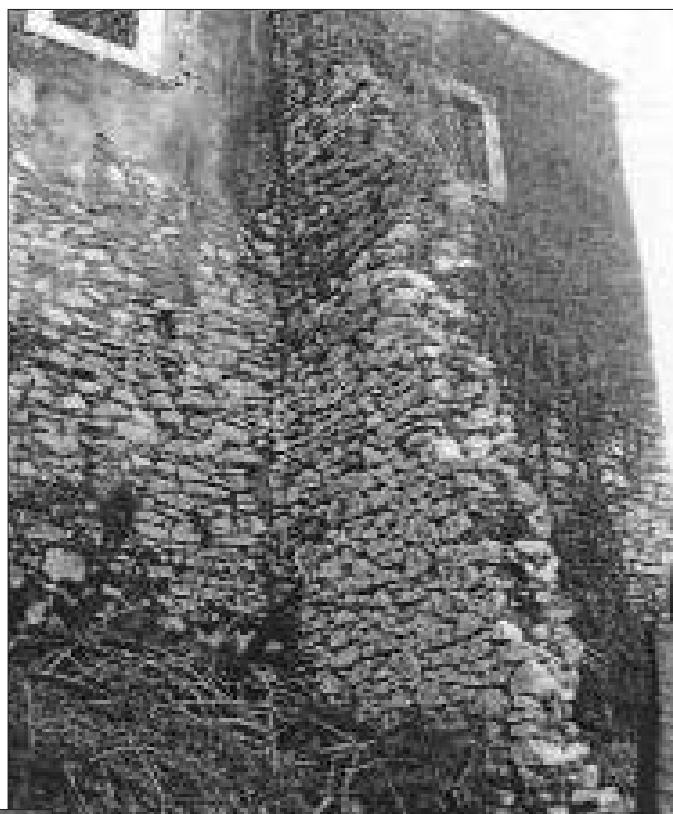
Fig. 6 - SPERONE CHE SORREGGE UN MURO PORTANTE DELLA CHIESA DI SANTA MARIA (LATO W)
