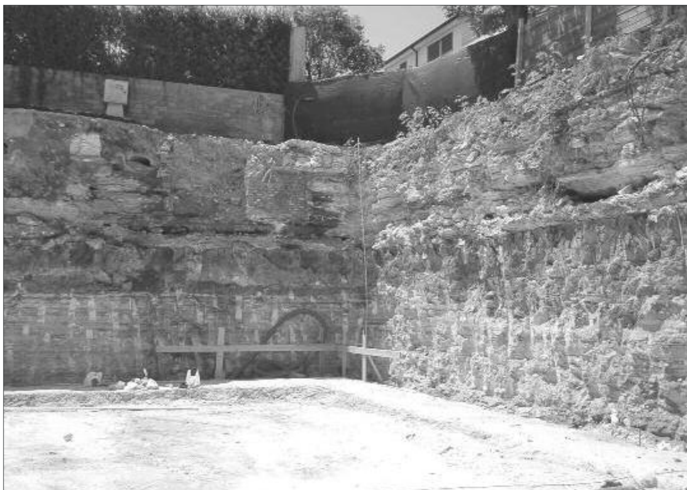
Foto 12 – LIVELLO DI HUMUS, FRAMMISTO A RELITTI DI TRAVERTINO CON EVIDENTI TRACCE DI INTERVENTI ANTROPICI
