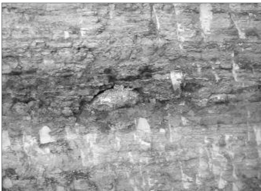
Foto 2 - TRATTI DELLA SEZIONE A LIVELLI NON UNIFORMI A CAUSA DELLE DEPRESSIONI
