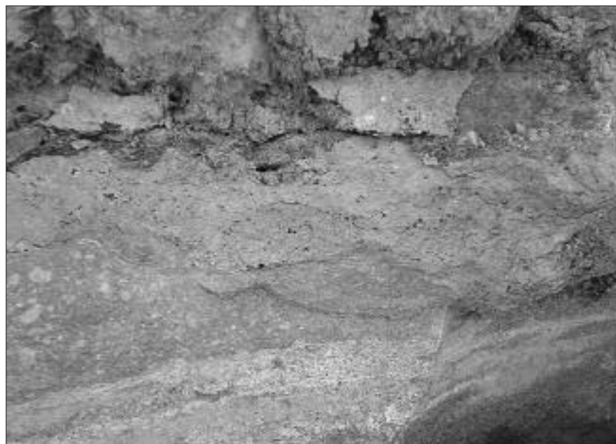
Foto 5 – TRACCIA DELLE DEFORMAZIONI TETTONICO/STRUTTURALI E DEL CARISMO
